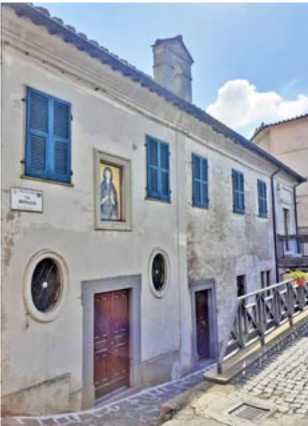
Asilo delle maestre pie Filippini in via Montinaccio
