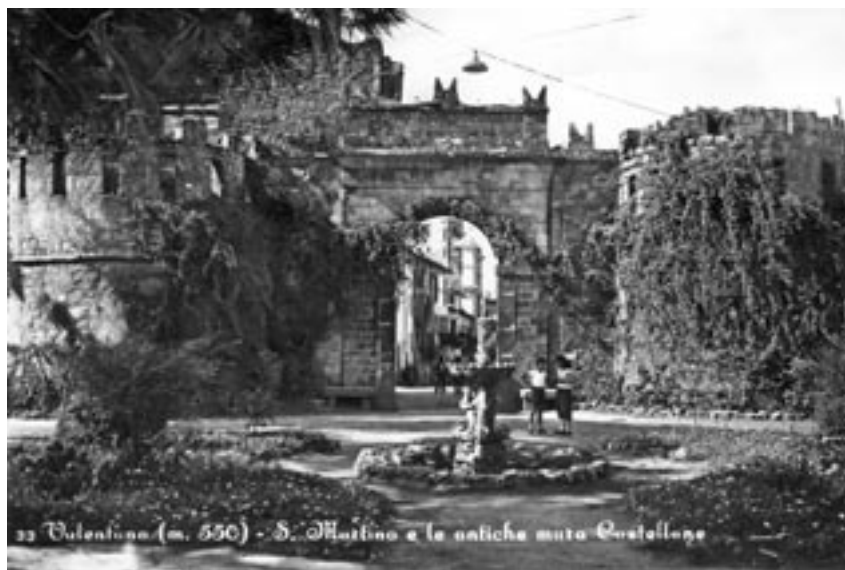
Una foto d'epoca del piazzale San Martino. Nonostante la scomparsa della chiesa, ubicata fino al 1859 alla sinistra della porta, la toponomastica del luogo è rimasta invariata
