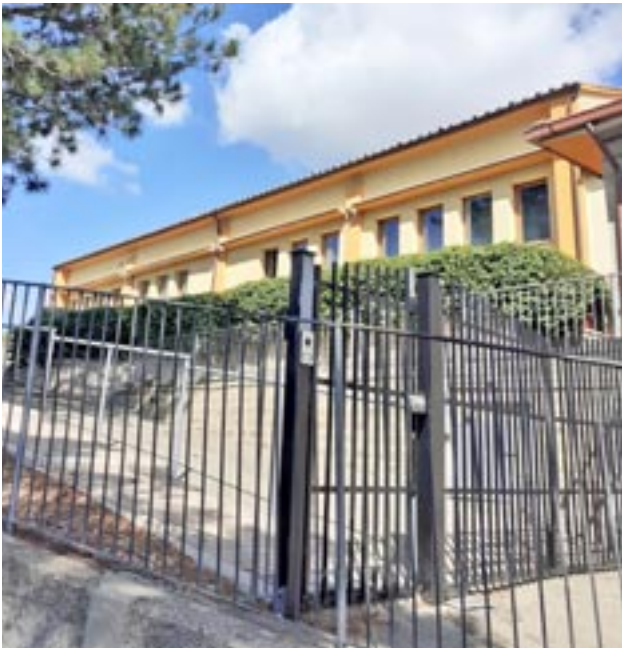
Imponente costruzione del 1966 per scuola media ed elementare, ora casa di riposo Villa Daniela
